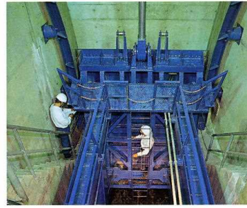
ゲートの点検状況
