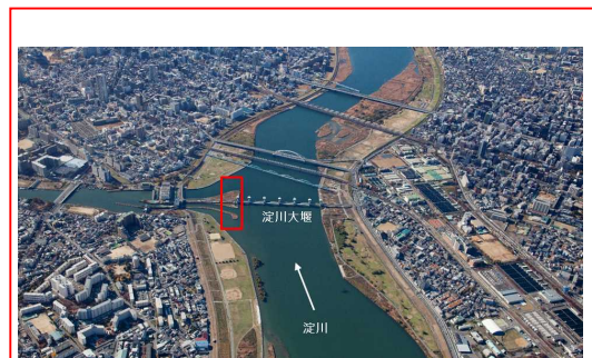
写真 4.3.4-1 淀川大堰閘門設置位置
