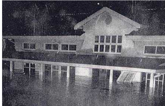
写真 3.3.1-5 亀岡駅 (昭和 28 年 9 月台風 13 号)
