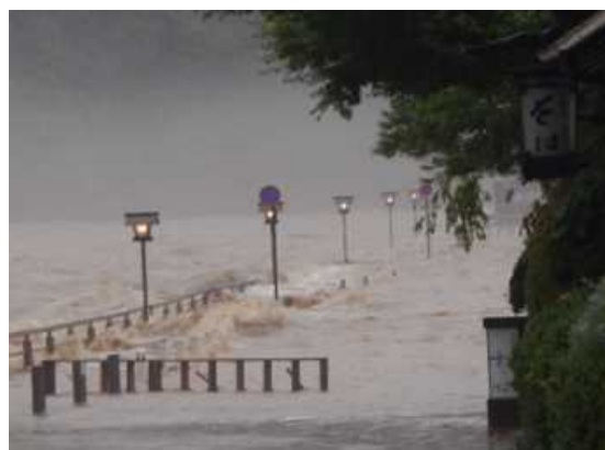
写真 3.3.1-7 嵐山地区 (平成 30 年 7 月豪雨)
