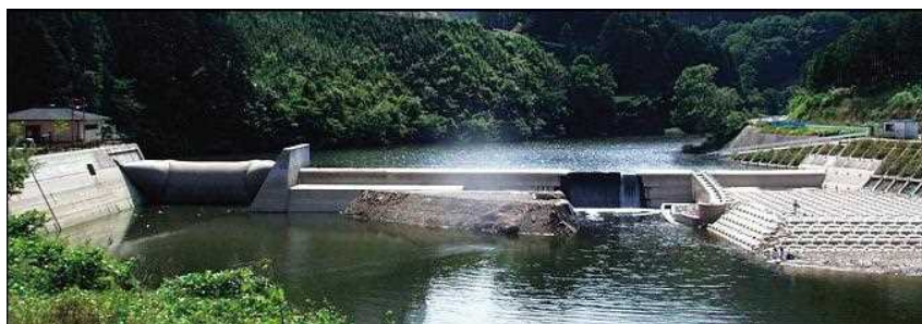
写真 4.2.5-4 副ダム（室生ダム）
