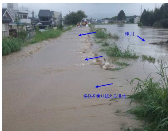
写真 3.3.1-6 久我地区 堤防越水 (平成 25 年台風 18 号)
