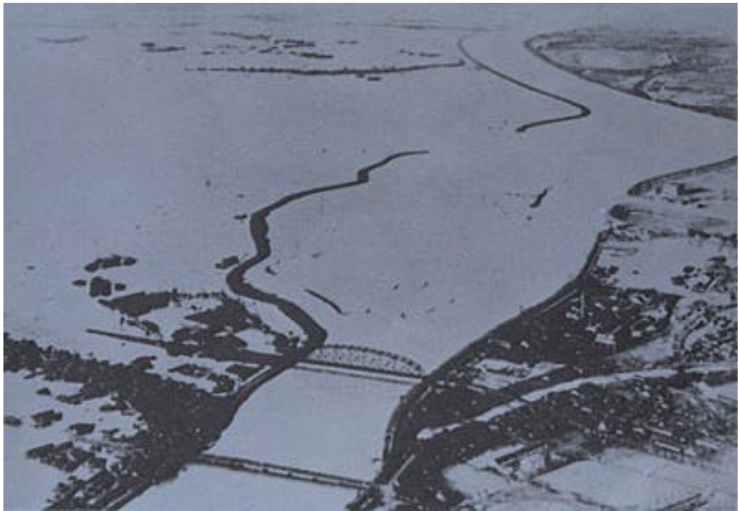
昭和 28 年 13 号台風による京都府久御山町付近の浸水
