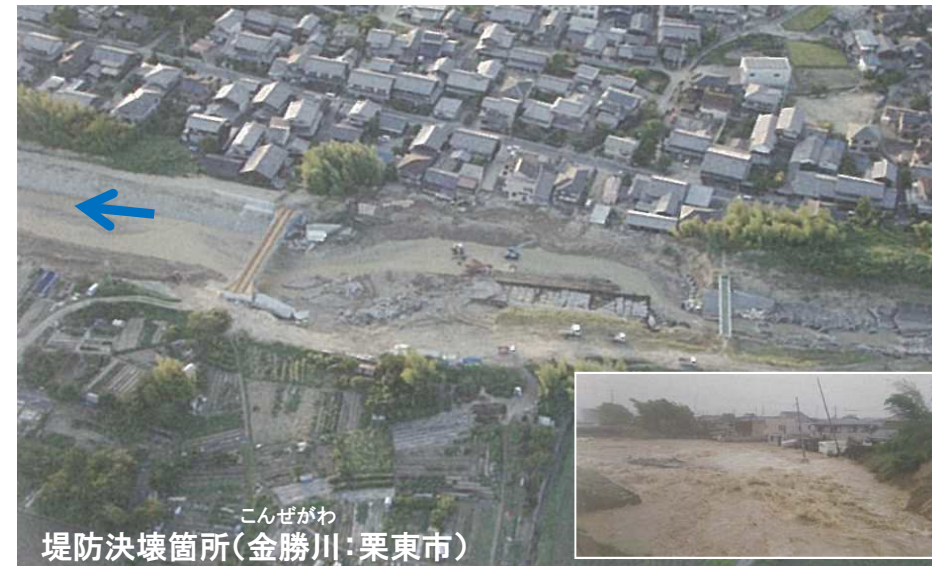
※台風18号に係る災害記録誌(滋賀県作成)より
