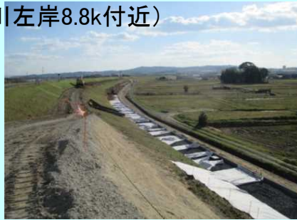
施工中(ドレーン工設置)
