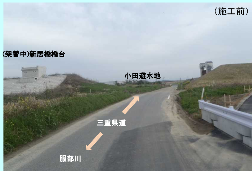
小田遊水地本川堤施工状況 (服部川左岸0.2k付近) ※平成27年度施工箇所
