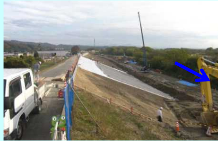
施工中(遮水シート設置)
