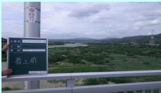
京都府綴喜郡井手町井手地先 木津川16.0k付近 右岸 着手前
