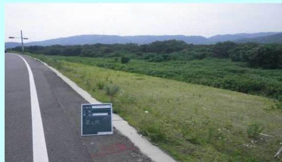
八幡市八幡科手地先 木津川0.4k付近 左岸 着手前
