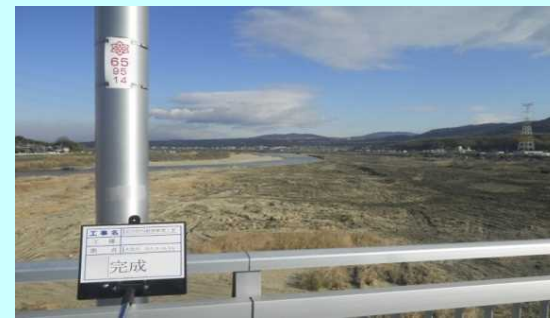
京都府綴喜郡井手町井手地先 木津川16.0k付近 右岸 完成
