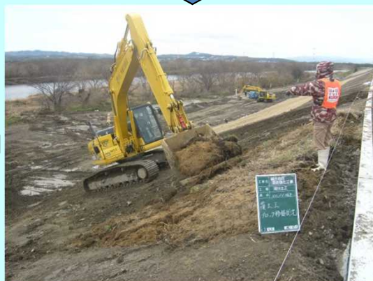
③表土の復元状況
