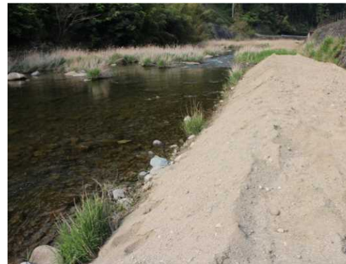
置土状況 出水前 (H26.5.9撮影、比奈知ダム下流)
