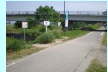
警告看板設置(桂川右岸15.8k付近)
