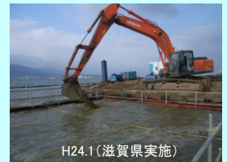
③覆砂として土砂を湖底へ投入 <草津市下笠地先>
