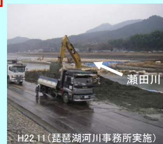
①瀬田川河道掘削工事による建設発生土(砂質土) <大津市南郷地先>
