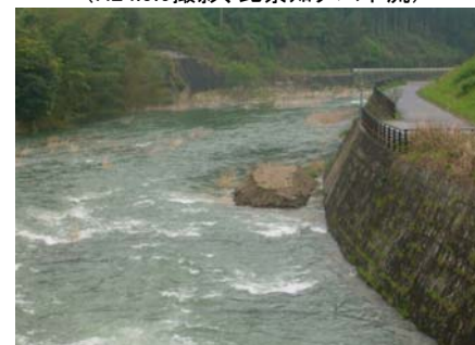
置土状況 フラッシュ放流中 (H24.5.9撮影、比奈知ダム下流)
