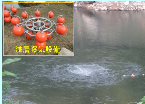
高山ダム 曝気増設状況
