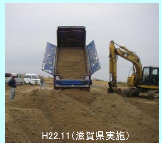
②南湖砂地回復事業地の土砂仮置ヤードへ運搬 <草津市下笠地先>
