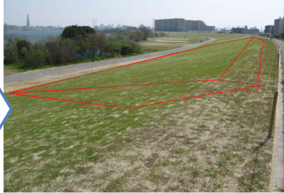
堤防強化(浸透対策)工事施工後
