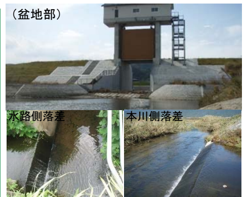
写真-1 支川との落差の例(上野遊水地)
