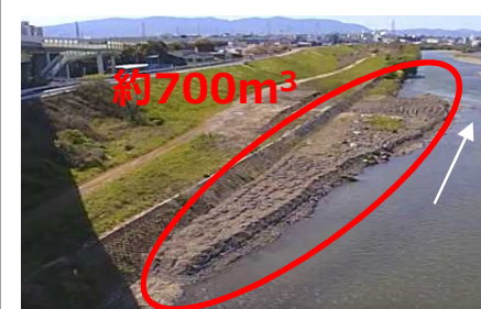
③ 京滋BP下流左岸（49.2k付近）
