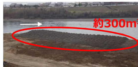
① 隠元橋下流右岸（46.8k付近）
