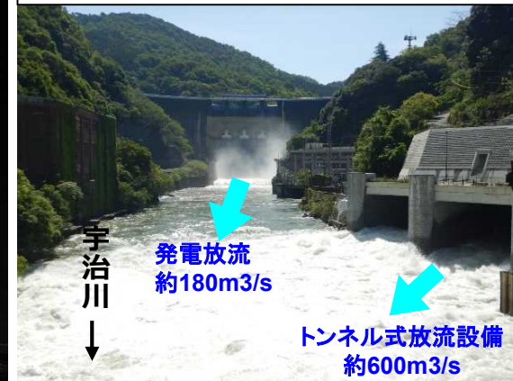
R5.5トンネル式放流設備の運用状況
