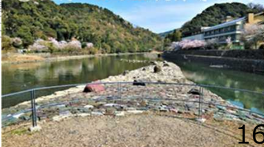
④石材による上流部導流堤
