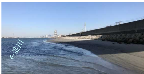
置き土による干潟整備(下流から上流を望む)
