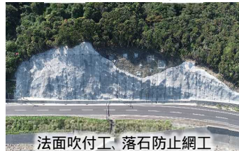
【法面・盛土対策】
