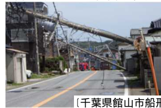
【台風等による電柱倒壊状況】
