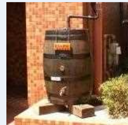
設置している雨水貯留タンク
