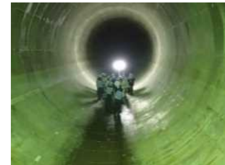
雨水貯留管の整備
