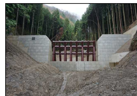
【治山：溪間工(治山ダム)】
