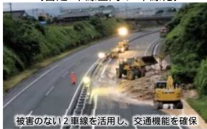
【暫定2車線区間の4車線化】
