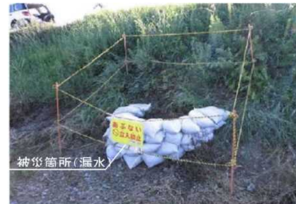
宇治川における堤防漏水の発生 (平成25年洪水)
