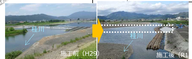
4号井堰の状況
