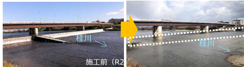
1号井堰の状況
