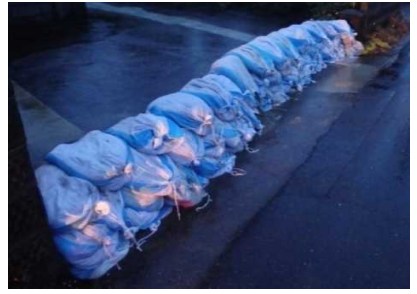
土のう設置完了(家屋浸水防止)
