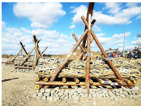
石や竹蛇籠を積み上げて設置
