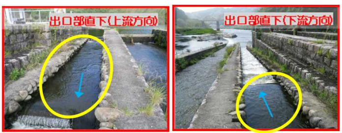
改良前の状況(平成27年6月)
