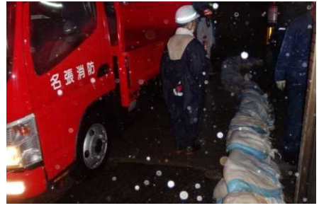
土のう設置状況(名張消防)
