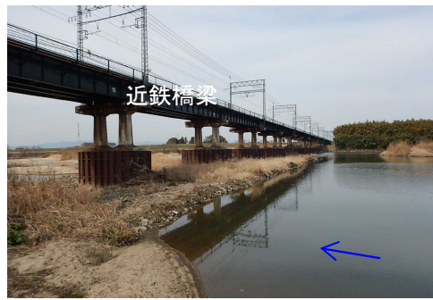
河床低下により橋梁の根入れが露出している。
