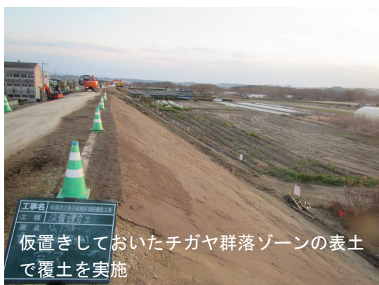
覆土の実施状況
