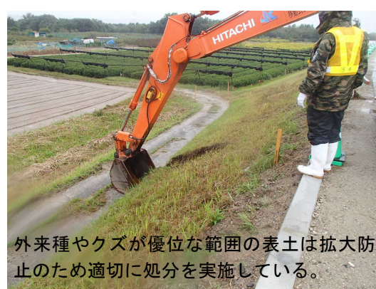
チガヤ群落が確認された箇所における表土はぎの実施状況
