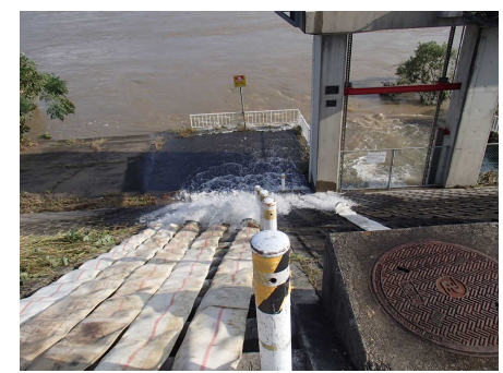
久保田樋門での排水作業状況
