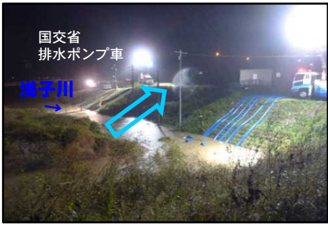
排水ポンプ車稼働状況 (平成29年10月台風21号)
