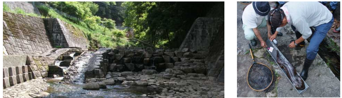
赤目滝床固工群(オオサンショウウオに配慮した砂防施設)
