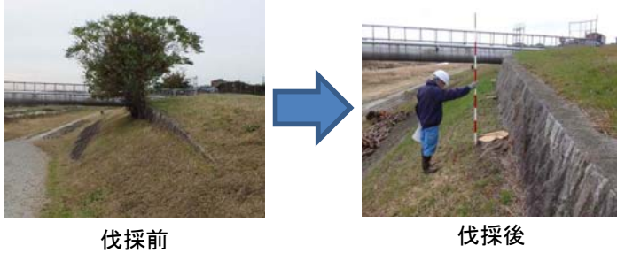
河川管理上支障となる樹木の伐採
