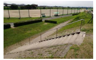
新設された手摺り(H28)
