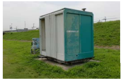
公園に設置されているトイレ
