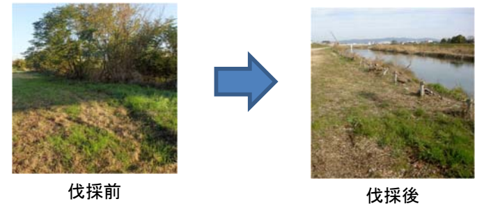
川の流れを阻害する樹木の伐採
