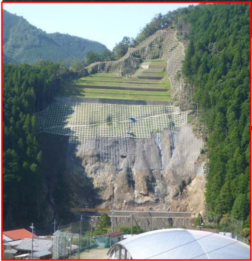
法枠工 施工状況
