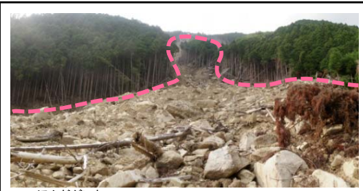
ほんだがいと ⑥本田垣内区域(田辺市西大谷) ・崩壊規模 3.24ha ・対策工: 溪間工 山腹工
