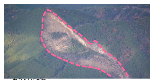
かみへいしがわ ⑤上平治川区域(田辺市本宮町皆地) ・崩壊規模 6.26ha ・対策工: 溪間工 山腹工
