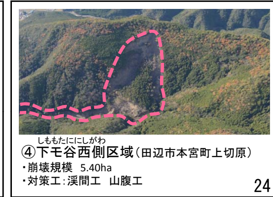
しもたににしがわ ④下毛谷西側区域(田辺市本宮町上切原) ・崩壊規模 5.40ha ・対策工: 溪間工 山腹工
