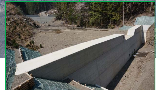
第1号谷止工 完成状況
