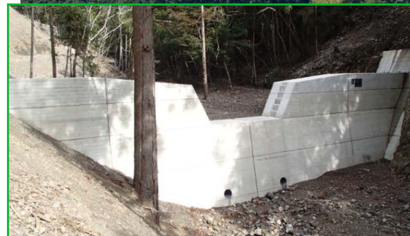
第1号谷止工 完成状況
