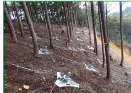
地山補強土工 完成状況
