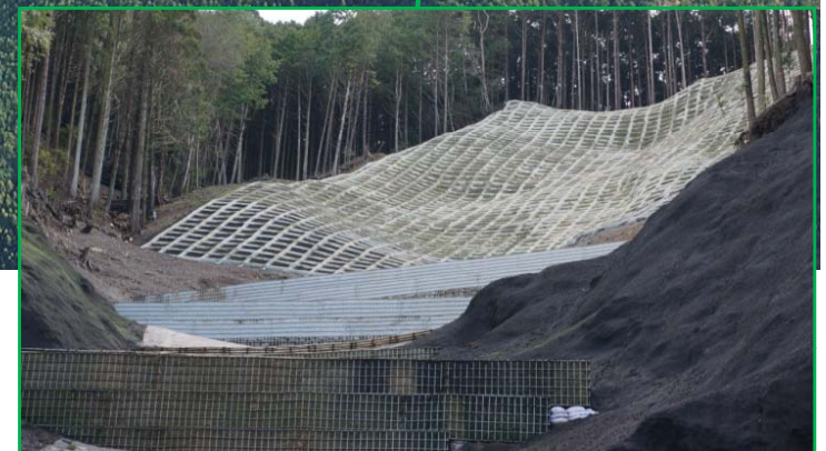
山腹工 完成状況
