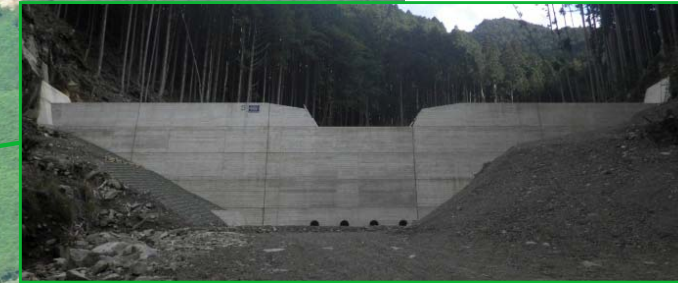
支流第1号谷止工 完成状況
