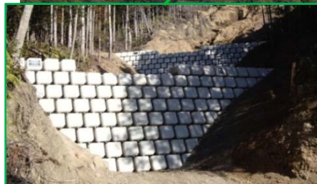
第2号谷止工 完成状況
