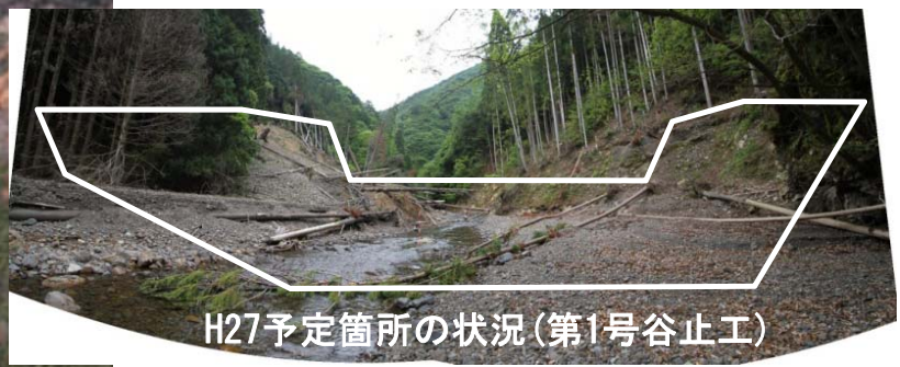
第1号谷止工 施工状況
