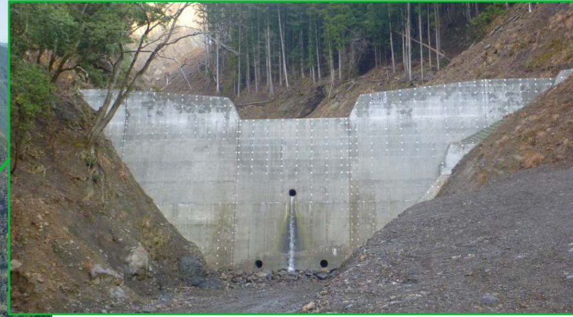
第4号谷止工 完成状況
