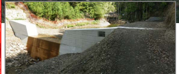
H24和歌山県施工
