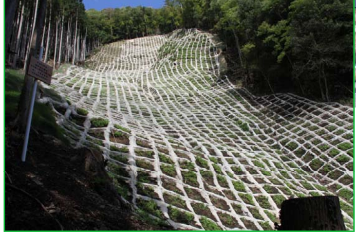
山腹工 完成状況(25年度完成)
