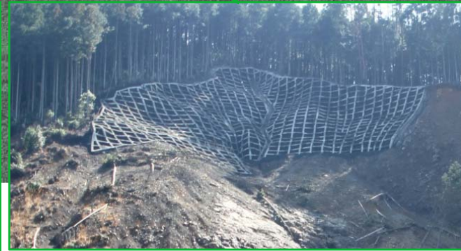
法枠工 施工状況
