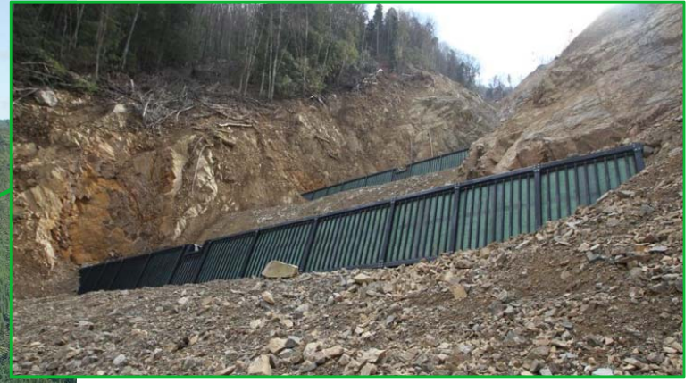
鋼製枠土留工 完成状況
