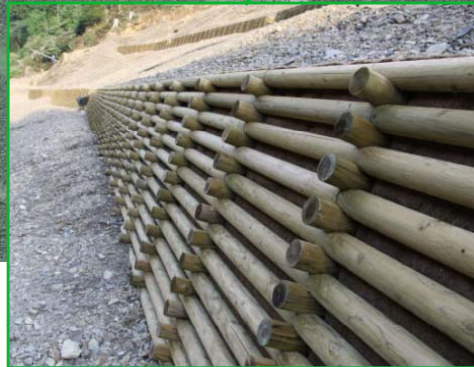
木製校倉式土留工完成状況
