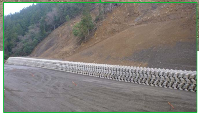
コンクリートブロック護岸工 完成状況
