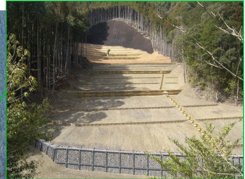
山腹工 完成状況
