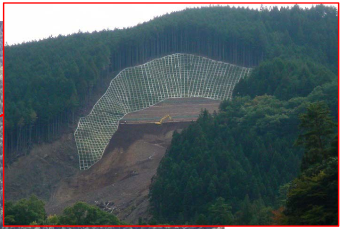
木製土留工 施工状況
