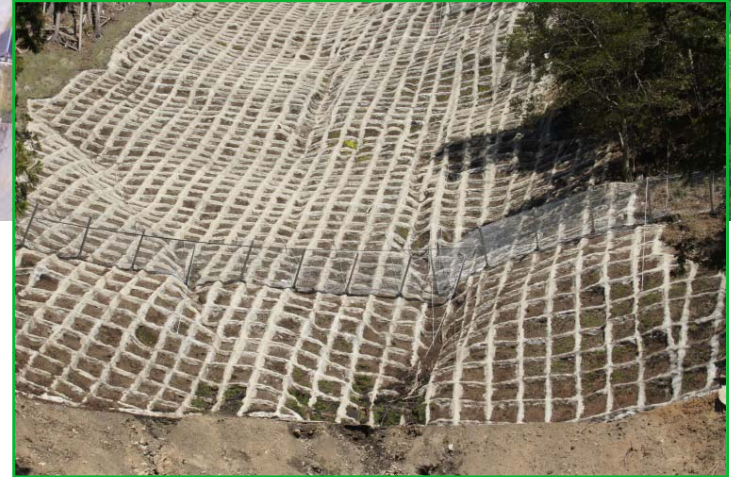
安全対策工 完成状況(26年度完成)
