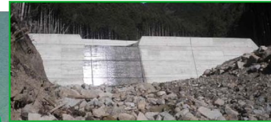
コンクリート土留工 完成状況
