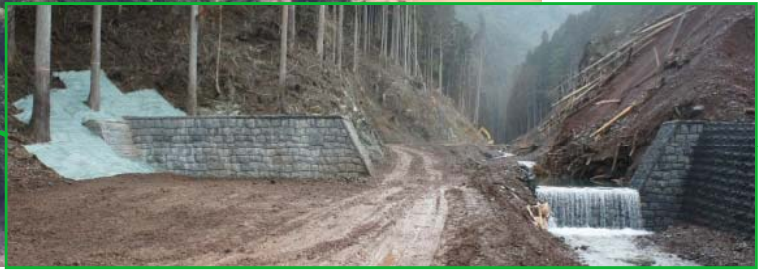
第2号床固工 完成状況
