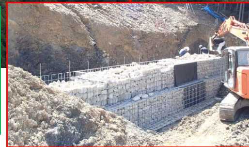
鋼製土留工 施工状況
