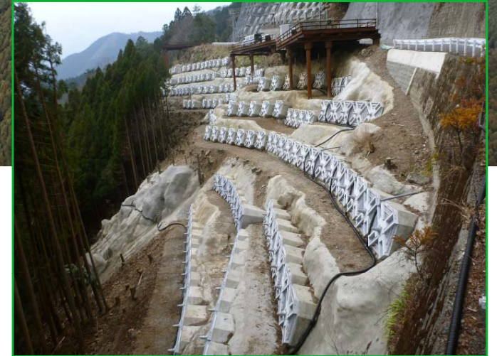
アンカー工 施工状況
