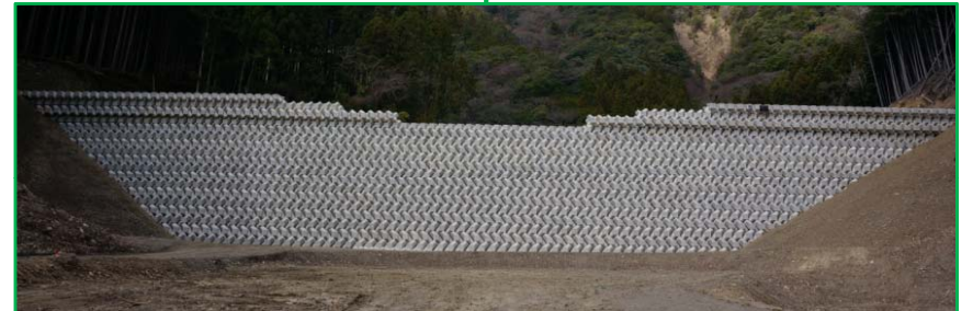
第4号谷止工 完成状況
