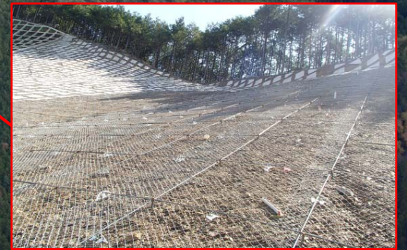
法枠工 施工状況
