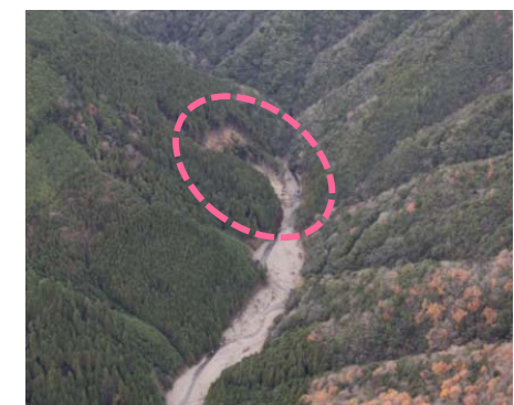
①三田谷地区(被災直後) ・崩壊規模 1.67ha ・対策: 谷止工、山腹工
