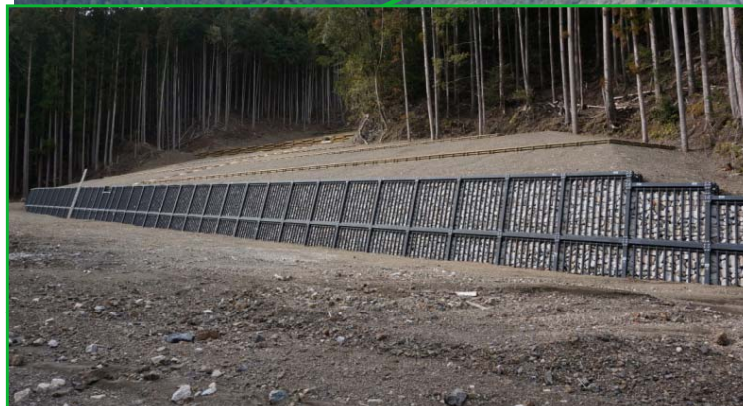
鋼製枠護岸工 完成状況
