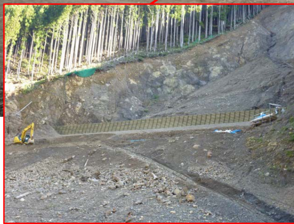
木製土留工 施工状況
