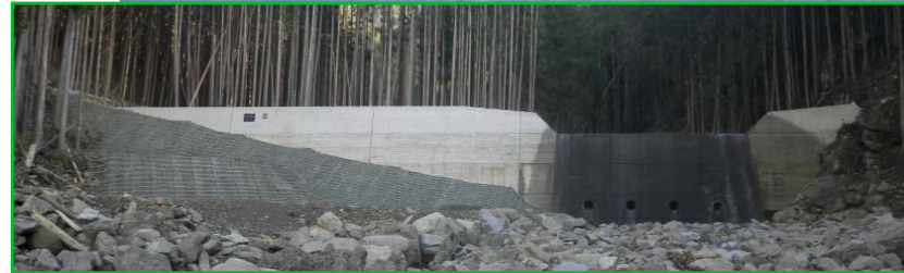
第3号谷止工 完成状況
