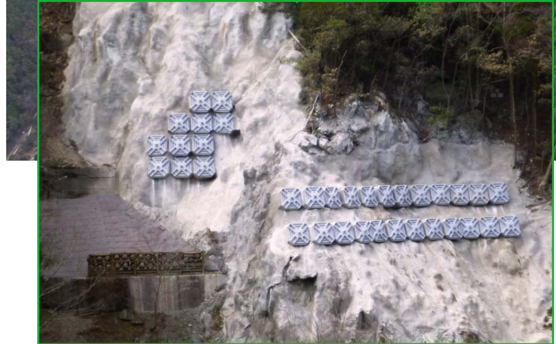
アンカー工 施工状況
