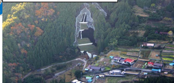
②十津川村山天の完成状況
