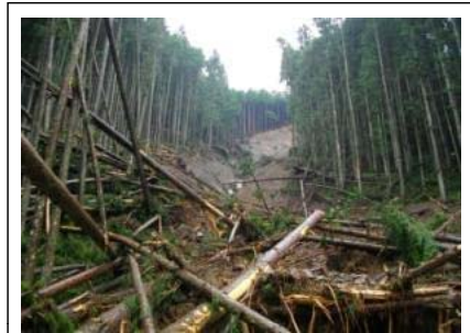
川合(深谷)地区(被災直後) ※H25事業完了 ・崩壊規模 0.54ha ・対策: 山腹工
