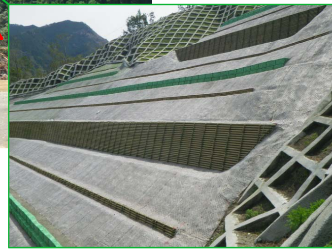
木製枝倉式土留工、木製筋工 完成状況
