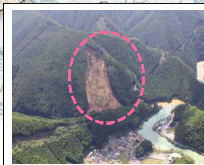
⑮坪内地区(被災直後) ・崩壊規模 4.3ha ・対策: 床固工
