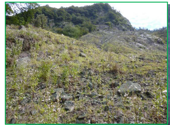
緑化工による復旧状況(H27年9月)
