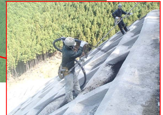
法枠工 施工状況
