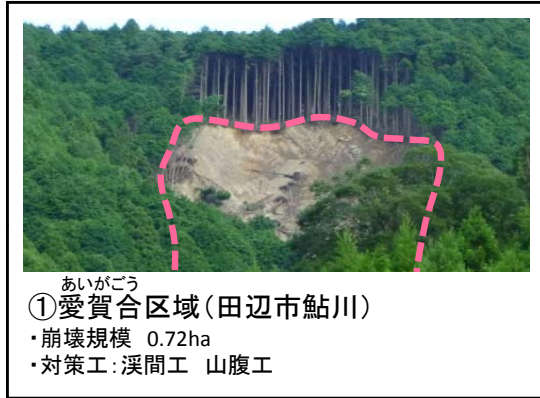
あいごう ①愛賀合区域(田辺市鮎川) ・崩壊規模 0.72ha ・対策工: 溪間工 山腹工
