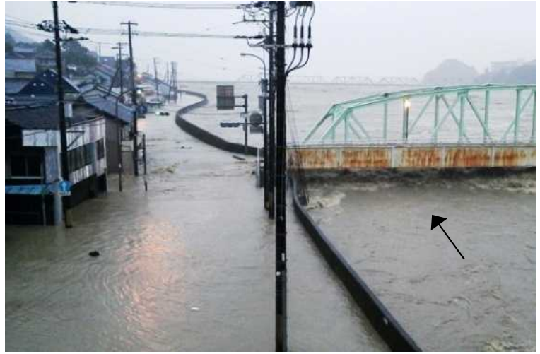
成川地区における堤防越水による浸水
