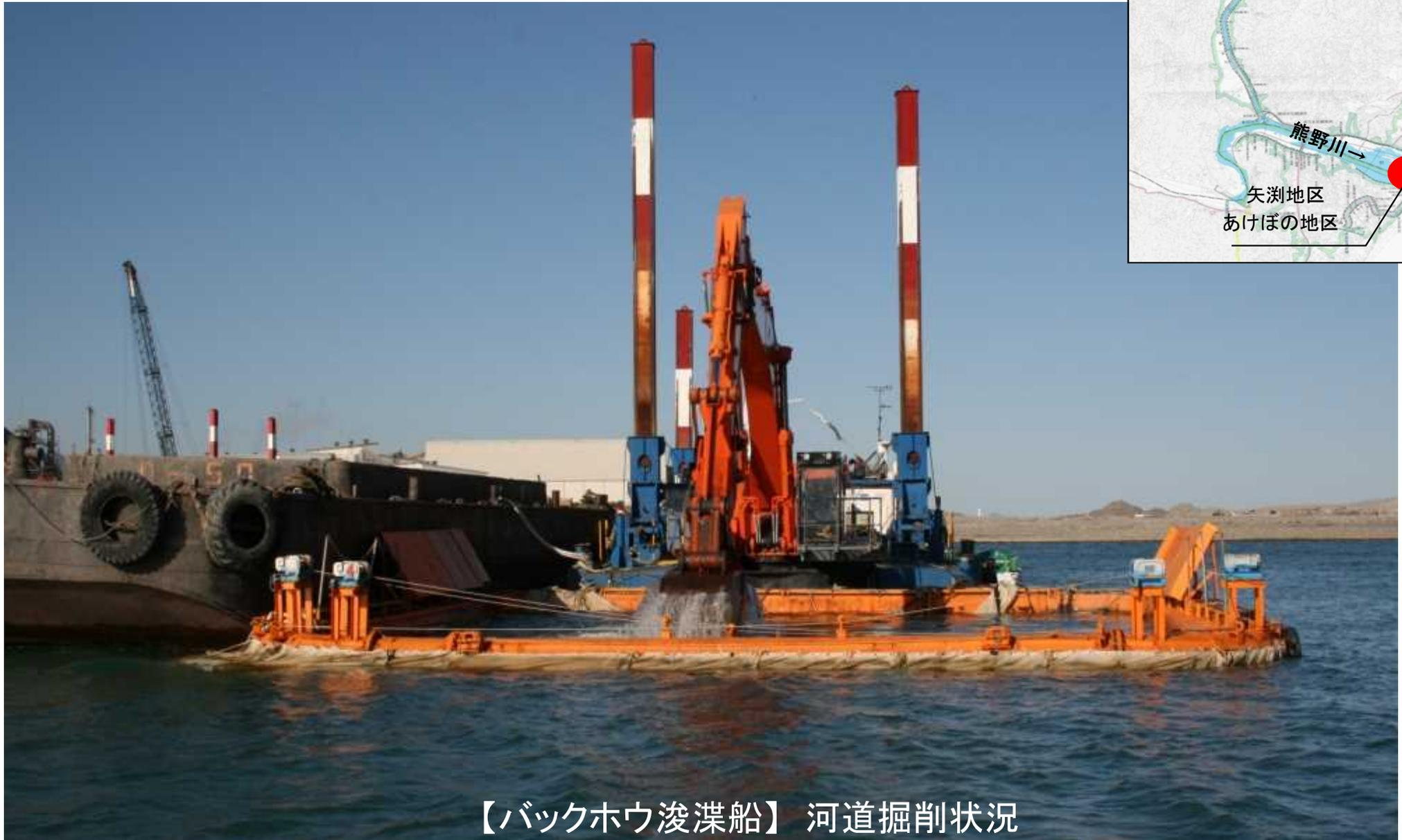
【バックホウ浚渫船】 河道掘削状況
