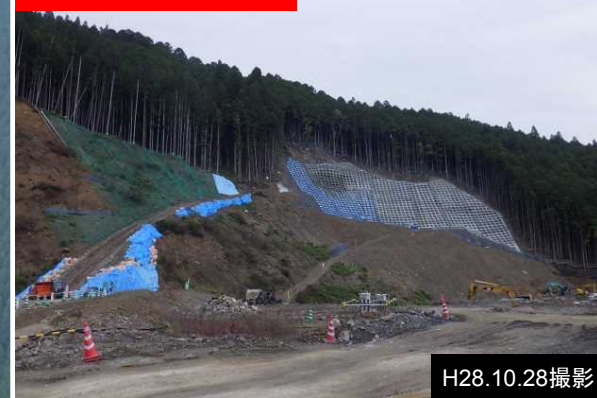
②法面工 施工状況
