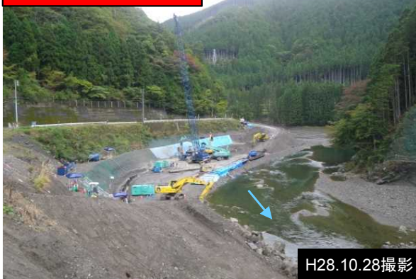
①護岸工 施工状況
