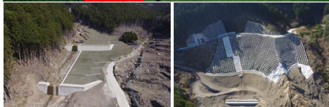
1号山腹工 (H25～) 写真は崩壊地下流部の土留工
