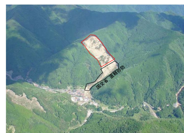
18 野迫川区域 北股 〔野迫川村檜股〕 山腹工 1箇所
