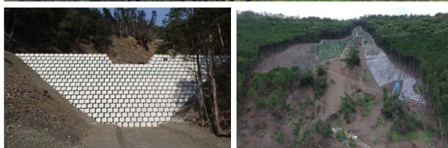
治山ダム工 (H25～) 写真は第2号治山ダム
