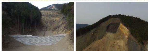
治山ダム工 (H25～) 写真は第7号治山ダム
