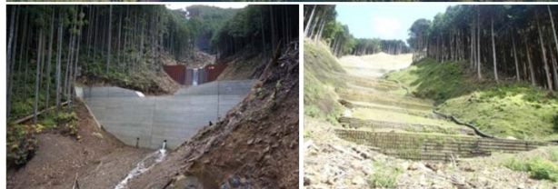
治山ダム工 (H24～) 写真は第6号、第7号治山ダム
