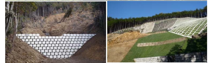
治山ダム工 (H24～) 写真は第3号治山ダム
