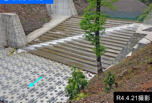
②砂防堰堤工
