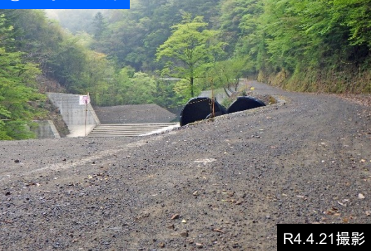
①工事用道路
