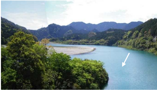
3.6 k 左岸から上流方向の眺望（手前は御船島）
