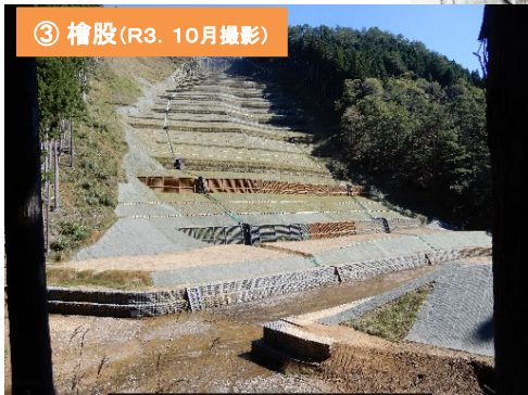
山腹工(大型かご砕土留工)
