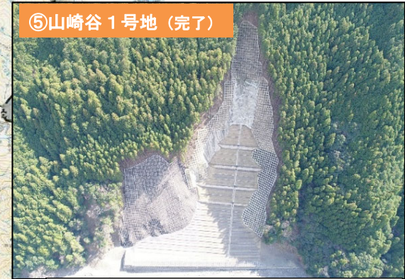
山腹工(法枠工・モルタル吹付工・緑化工) 溪間工(護岸工)
