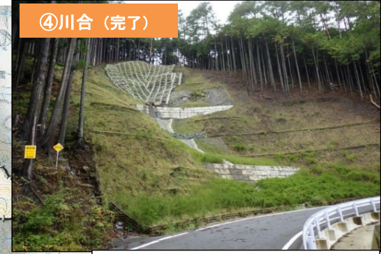
山腹工(土留工・法枠工・緑化工)
