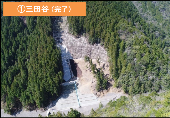
溪間工(鋼製谷止工・コンクリート護岸工) 山腹工(簡易法枠工・モルタル吹付工・コンクリート土留工・緑化工)
