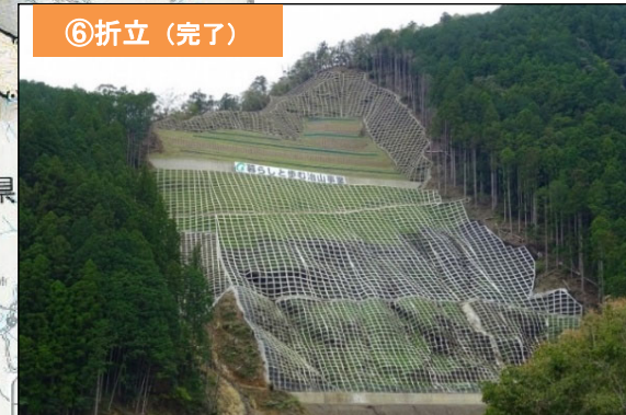
山腹工(法枠工・土留工・緑化工)
