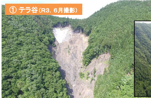
山腹工(簡易法砕吹付工・モルタル吹付工)
