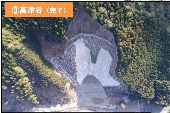
山腹工(法枠工・モルタル吹付工・緑化工) 溪間工(谷止工・護岸工)
