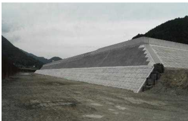
図－2.3 相野谷川輪中堤（高岡地区）
