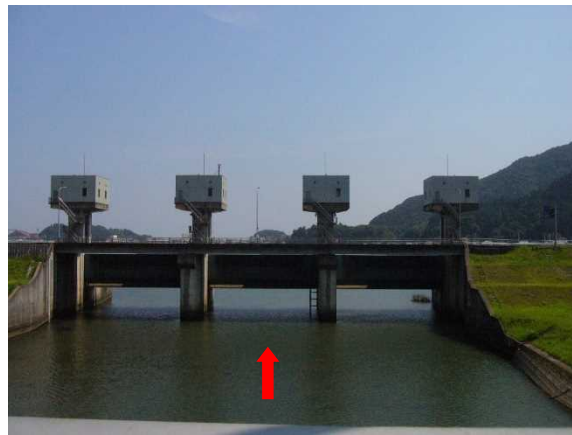
図-2.37 鮎田水門（相野谷川合流点）
