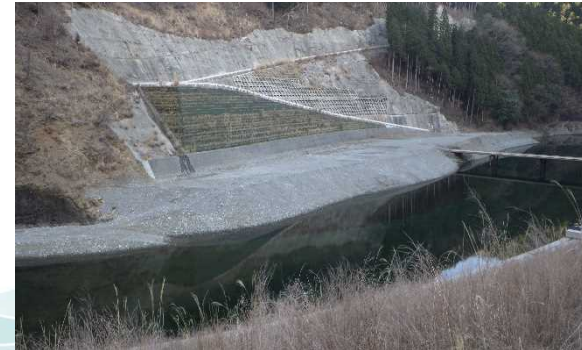
●No.6付近状況 堆積土砂除去後（上流から撮影）
