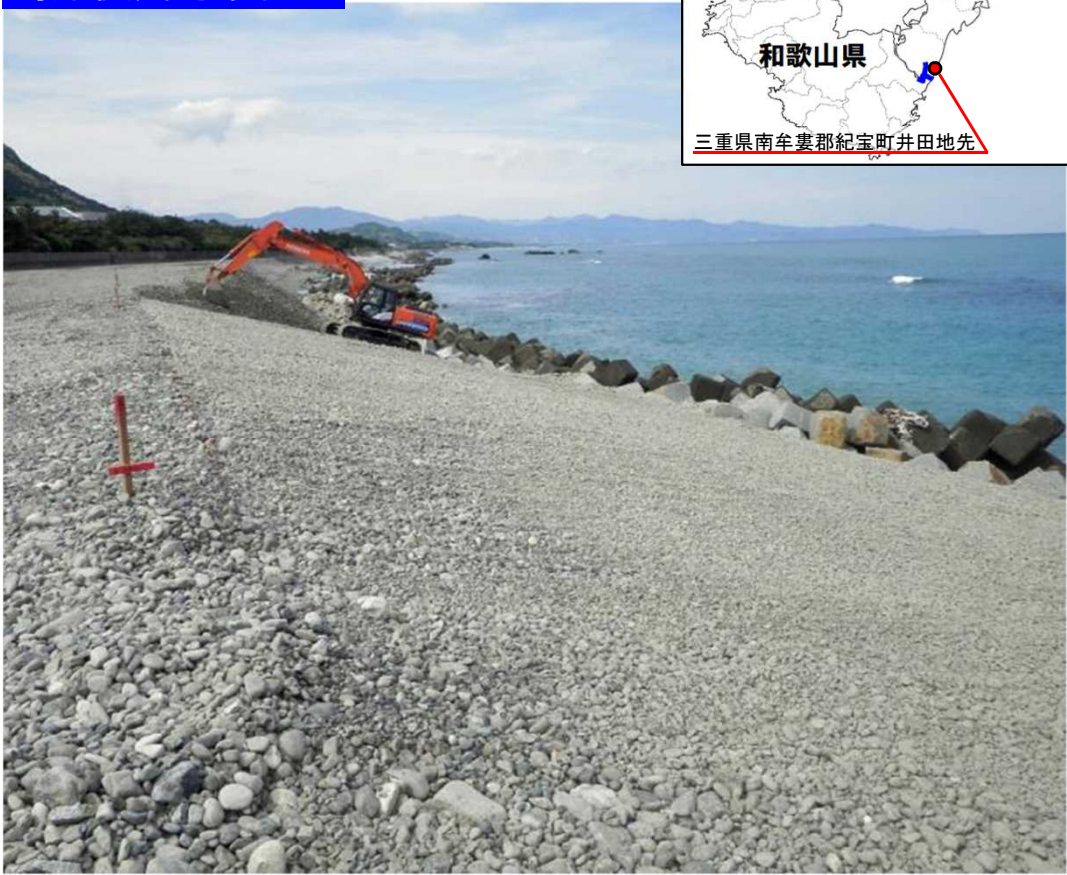
海岸侵食対策状況
