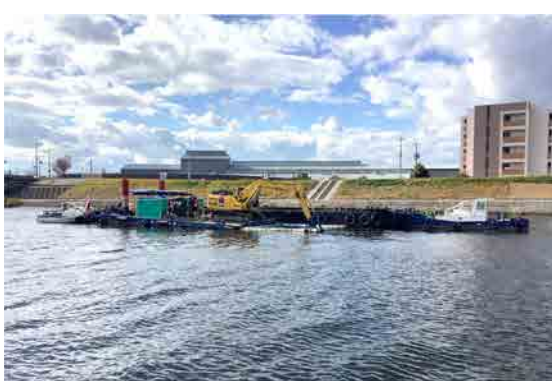
戸ノ内地区河道掘削(国土交通省)
