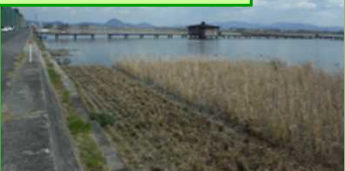
水質改善（植生護岸工）
