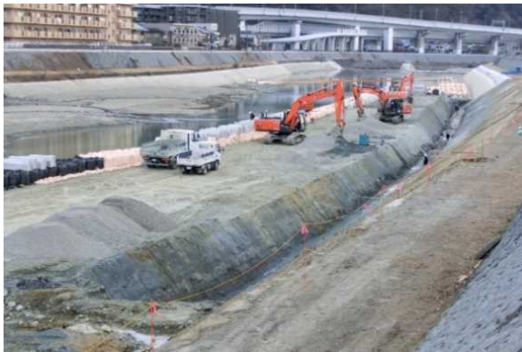
出在家地区河道掘削（国土交通省）
