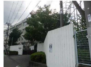
浸水深4.6m第四小学校正門
