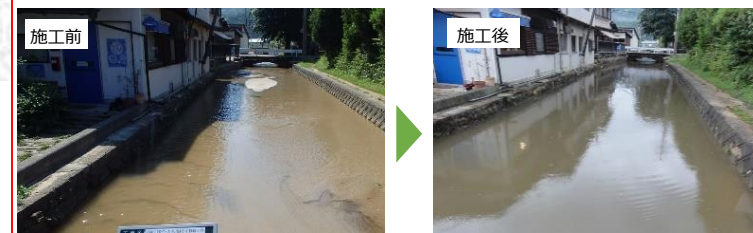
図-3 神子川維持掘削 (丹後広域振興局)
