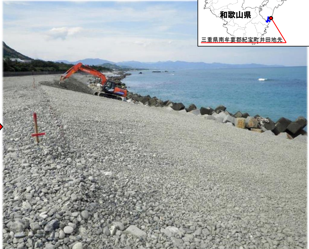
海岸侵食対策状況
