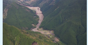
熊野川床固工群
