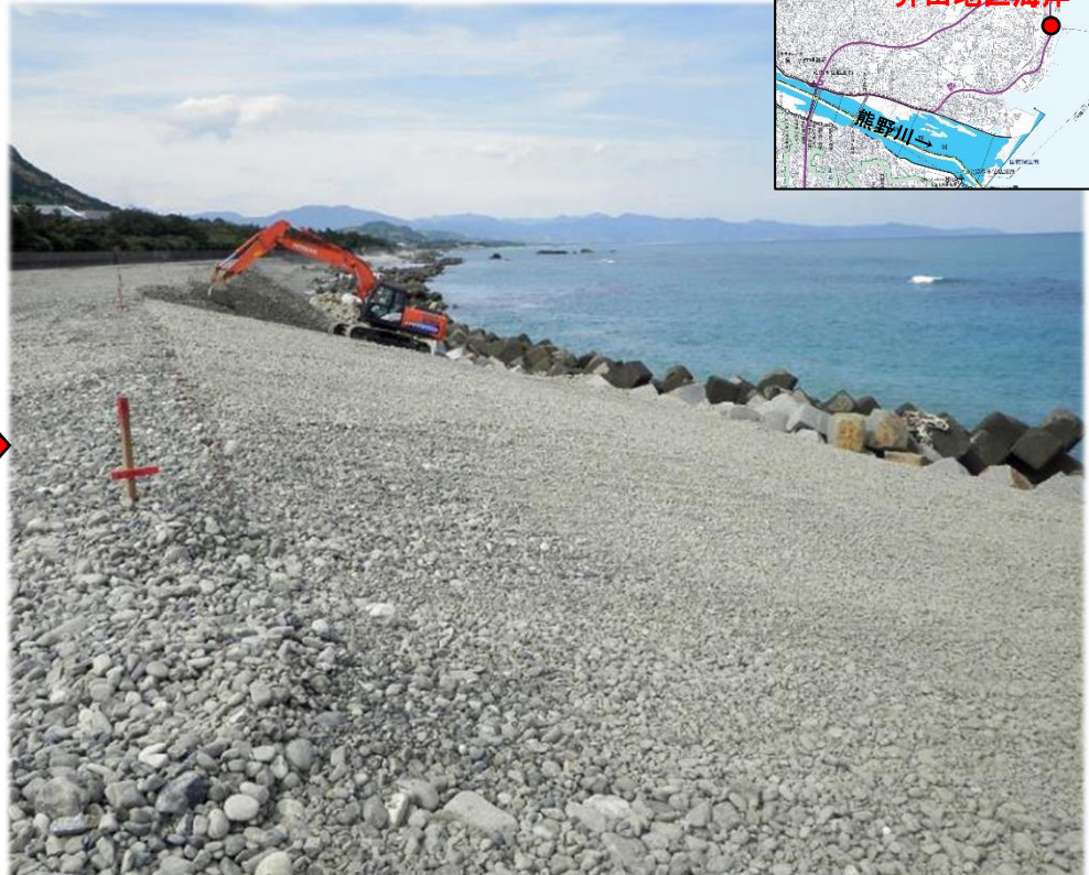
海岸侵食対策状況
