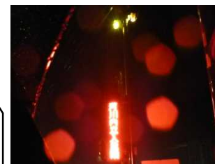
放流時点灯状況
