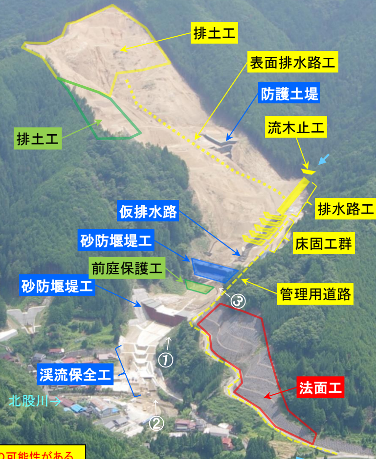
③砂防堰堤工
