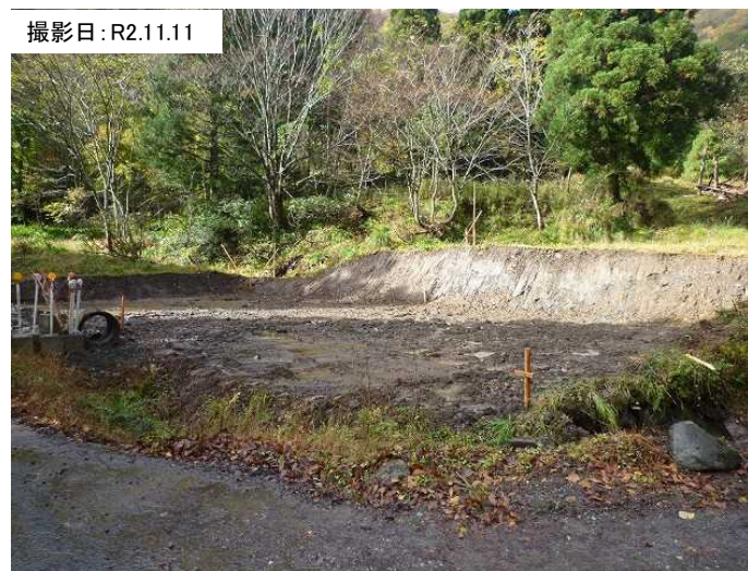
小原地区施工状況
