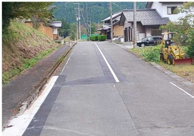
② 施工完了
