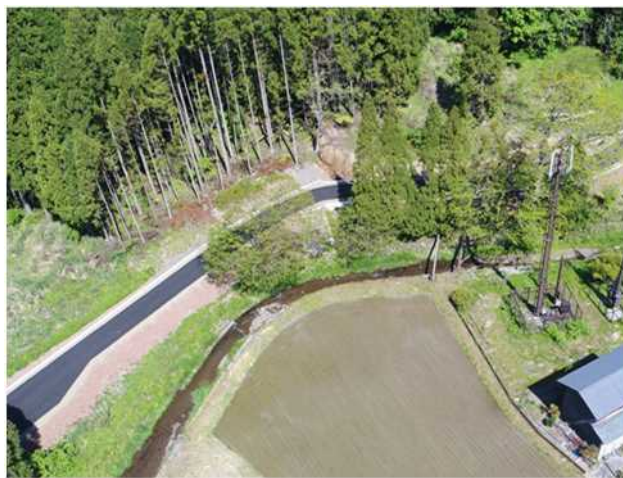
② 施工完了
