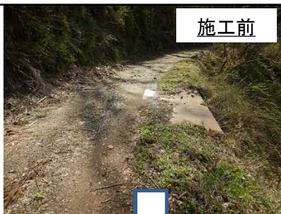
路肩補修① 奥川並0.5K+50
