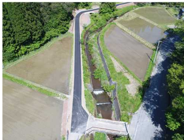
① 施工完了
