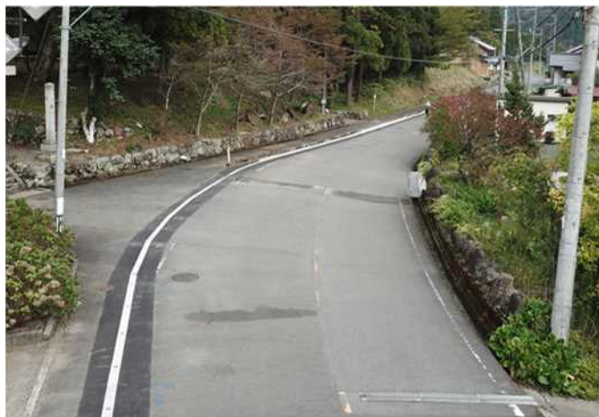
① 施工完了
