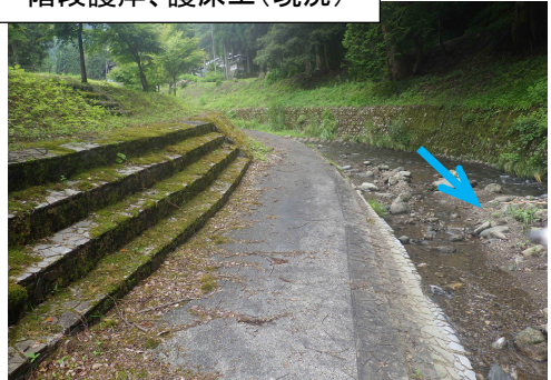
階段護岸、護床工(現況)
