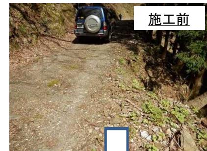
路肩補修③ 奥川並2.6K+85
