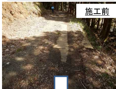
路肩補修② 奥川並2.6K
