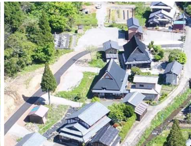
③ 施工完了
