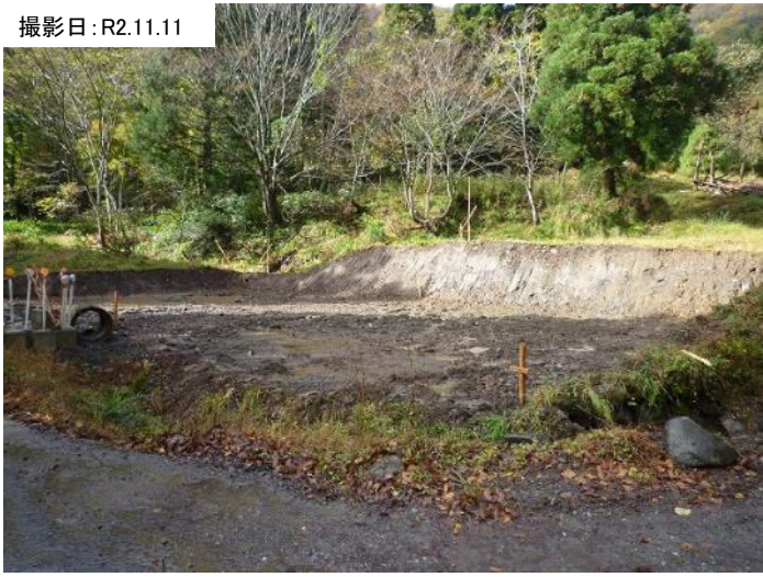
小原地区施工状況
