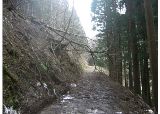
倒木(水没予定地の荒廃状況)
