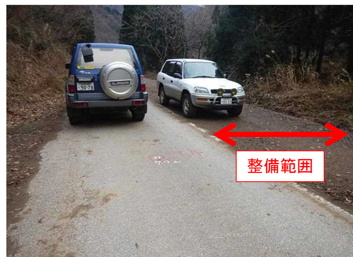
施工後(土工完了)
