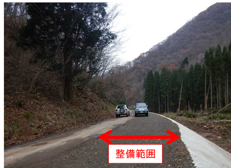
施工後(土工完了)
