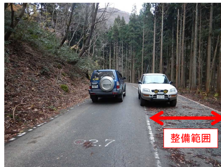
施工後(土工完了)
