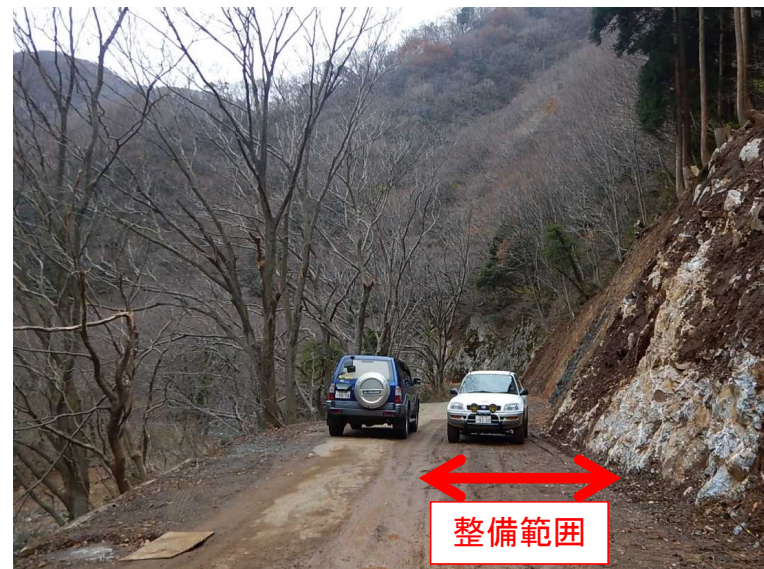
施工後(土工完了)
