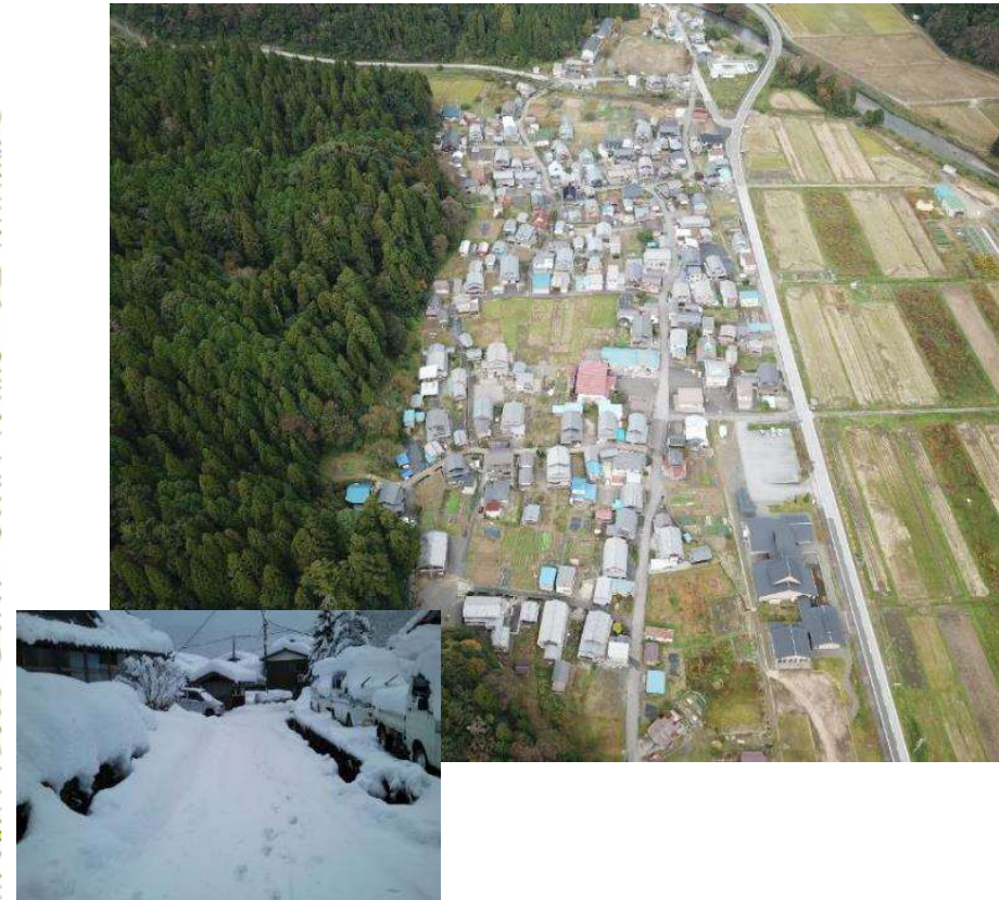
消雪施設整備
