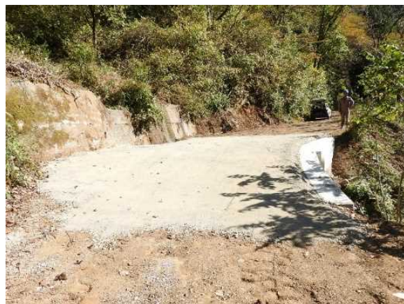
R4年度 整備完了(沢水処理)
