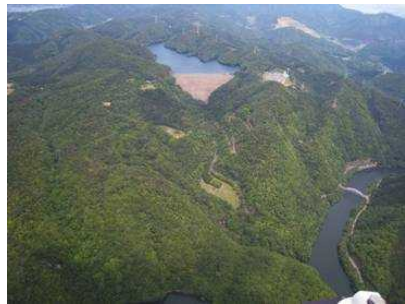
喜撰山ダム（揚水式発電の上池）
