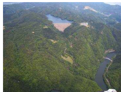
喜撰山ダム（揚水式発電の上池）
