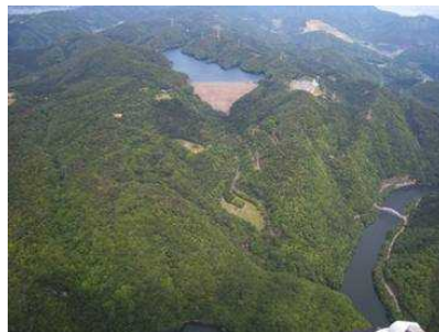
喜撰山ダム（揚水式発電の上池）
