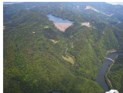
喜撰山ダム（揚水式発電の上池）
