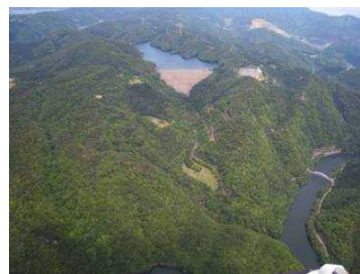
喜撰山ダム（揚水式発電の上池）
