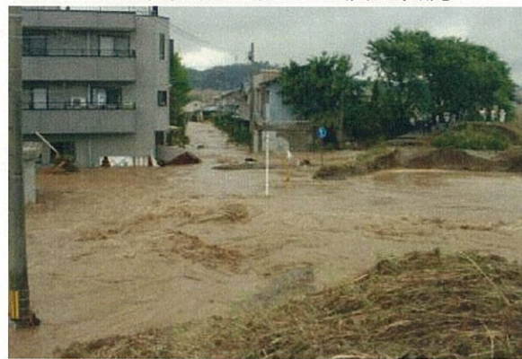
平成16年7月洪水（福井豪雨） 足羽川の堤防が決壊（福井市春日）
