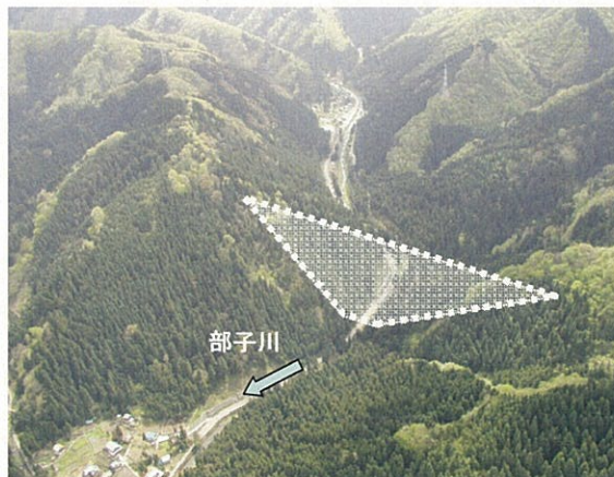
足羽川ダム(建設予定地)
