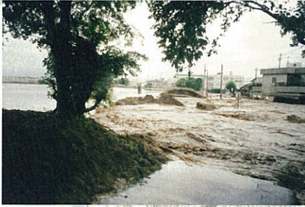
破堤地点（福井市春日）
