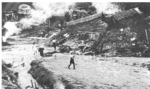
写真 2.2-1 甲賀市信楽町多羅尾村の家屋被害
