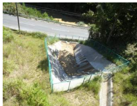
写真 3.2-1 沈砂池の設置状況
