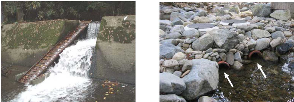
移動経路の確保状況
