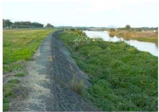
写真 2.3-5 コンクリート護岸
