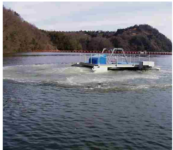
図 5.6.1-2 曝気循環設備
