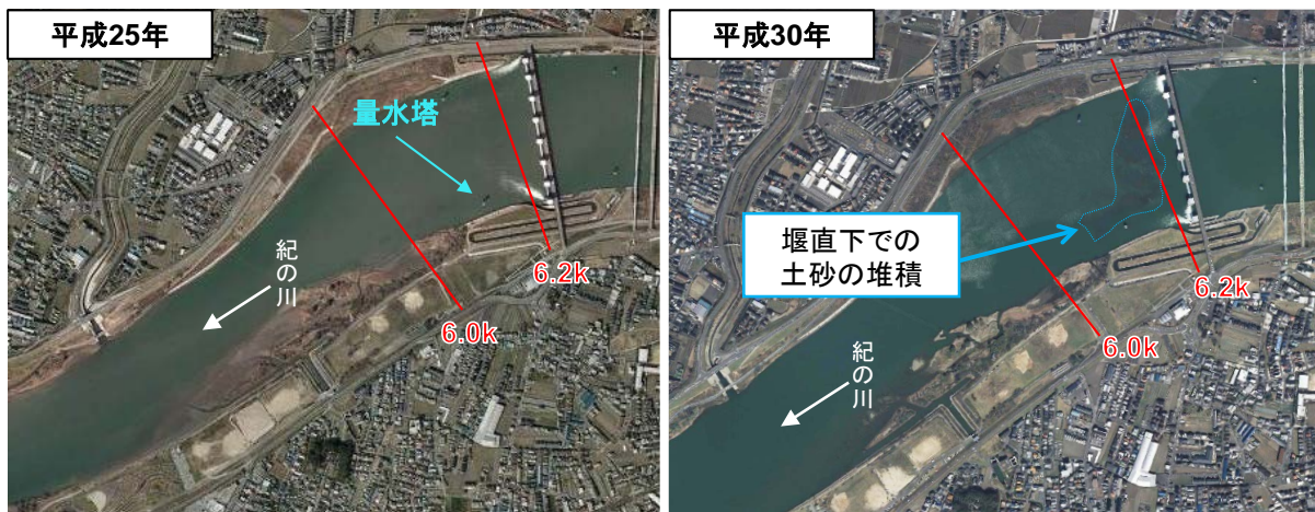
図 4.3-6 大堰直下流の堆砂箇所
