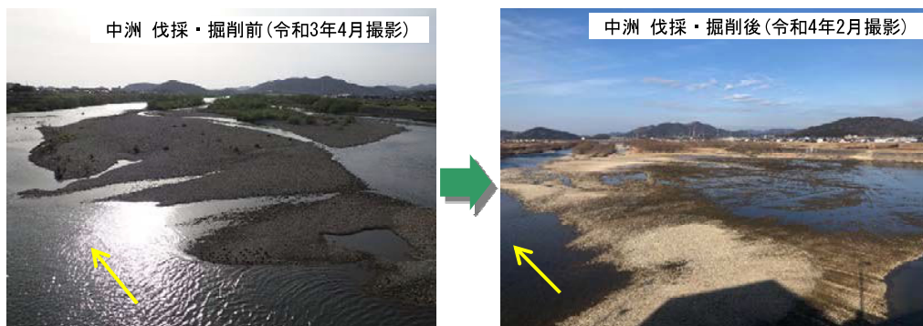
写真4.3-1 掘削前後の堰下流の状況
