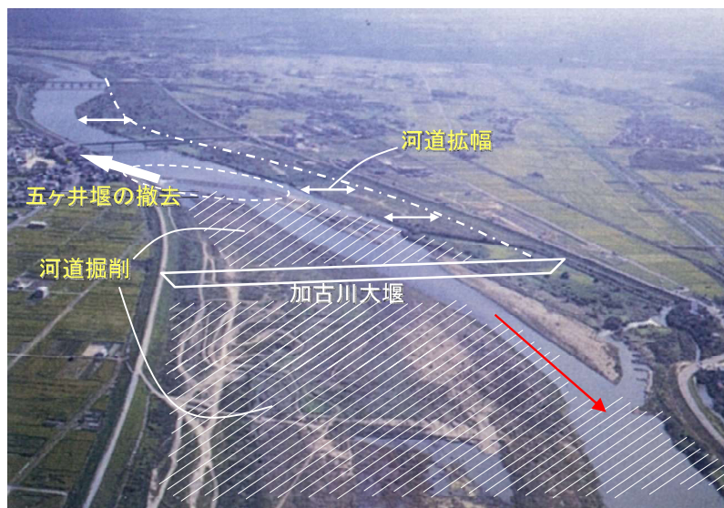
図 1.2-2 河川改修の状況
