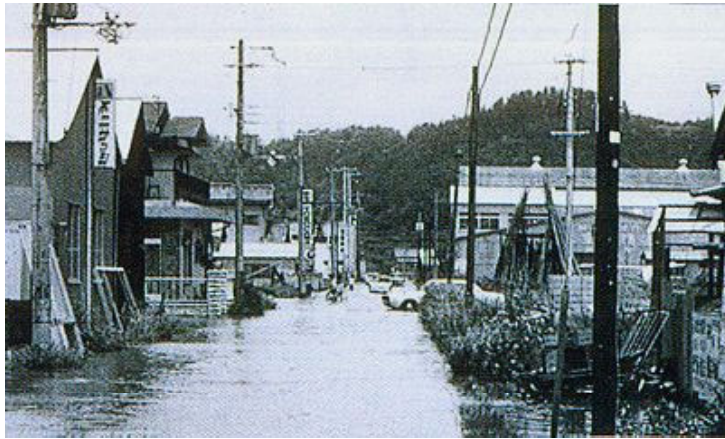
昭和 49 年 7 月 台風 8 号による水害の状況
